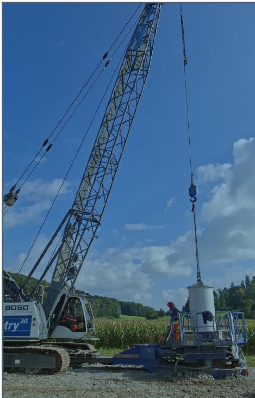
Eine Impression von der Baustelle «Neubau GWP Breiten, Zufikon»
