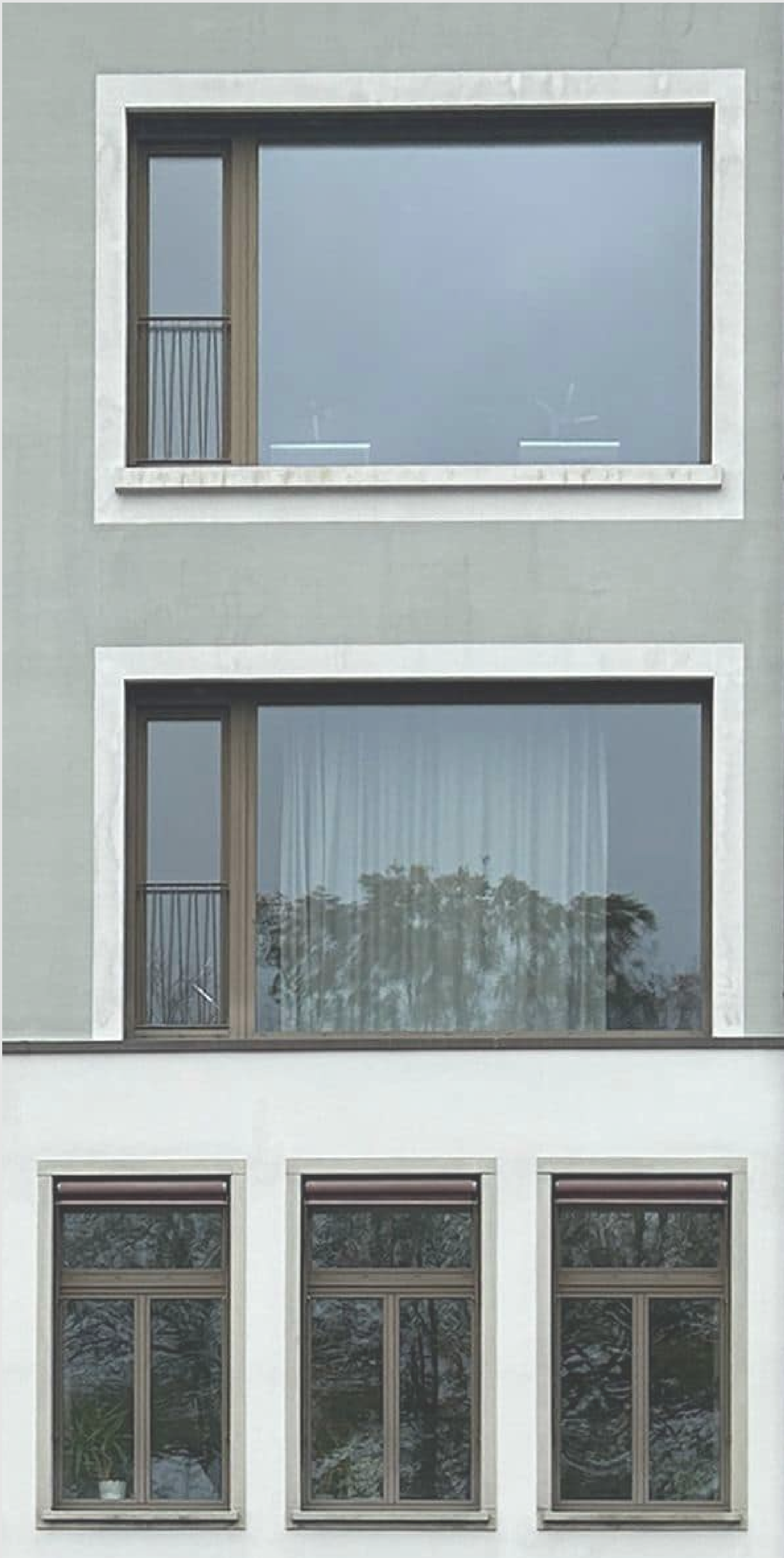
Erweiterung Oberstufenzentrum Hüslerberg, Niederrohrdorf
