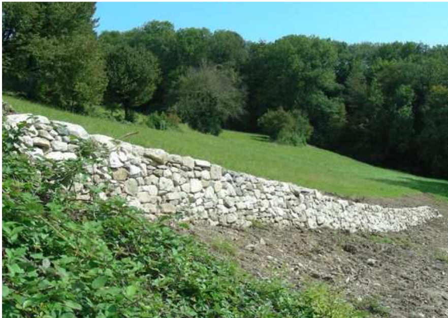
Neue Trockenmauer im Bändelacher
