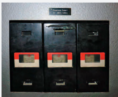
Einspeisung Pumpe (defekte Abdeckung)
