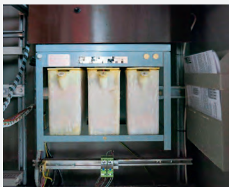
Pumpenanlassverfahren mittels Elektrolytanlasser (undicht/veraltetes System)
