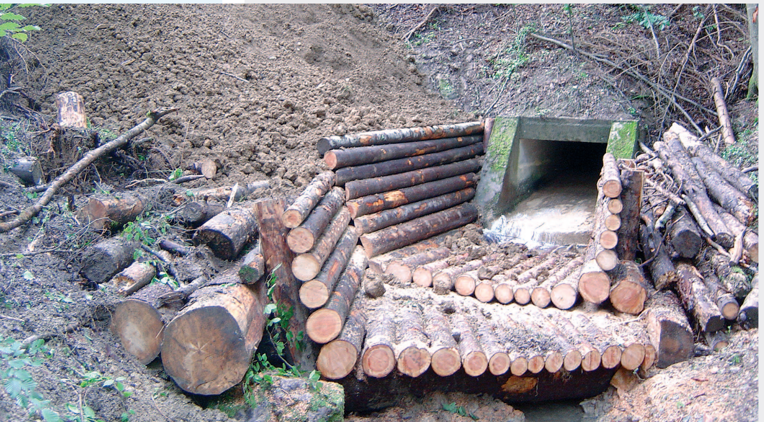
Bau eines Böschungsschutzes im Forstrevier Heitersberg
