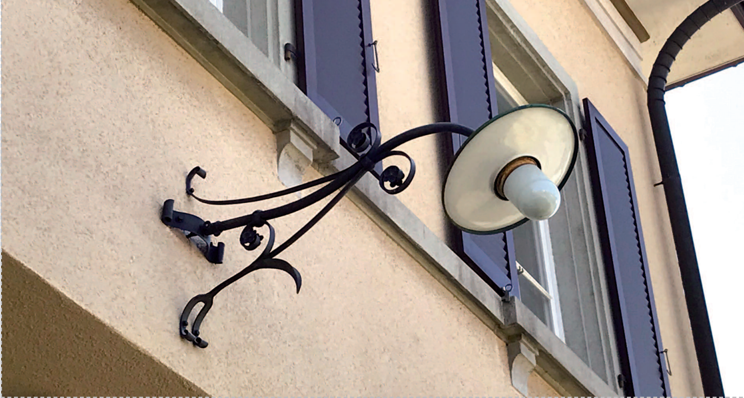
Fassadendetail am alten Schulhaus
